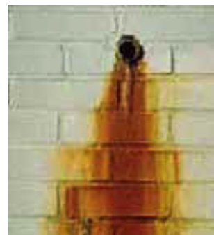
▲ Figura 23.29 La presencia de sales de hierro disueltas en una red de distribución de agua produce manchas debidas a depósitos de \text{Fe}_2\text{O}_3 .
