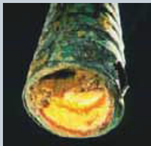
◀ Figura 18.18 Corte de un tubo de agua que ha quedado recubierto en su interior por \text{CaCO}_3 y otras sales insolubles depositadas por el agua dura.
