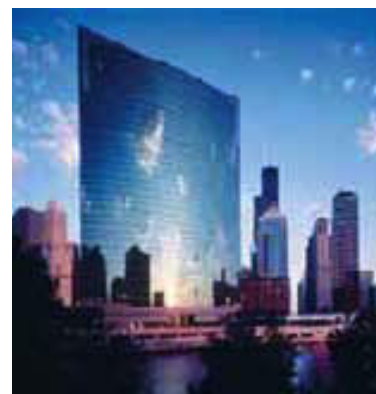
▲ Figura 12.31 Los paneles de vidrio que forman las paredes exteriores de este edificio tienen una delgada película metálica que refleja una fracción considerable de la luz exterior. El vidrio reflejante ofrece privacidad, reduce el deslumbramiento interior y reduce la carga de enfriamiento del edificio cuando hace calor.
